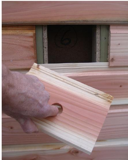
face du bardage). En outre, l'accès à la cavité doit mesurer 20 à 25 mm sur 100 mm de large. Ces dimensions sont indicatives. La taille de l'accès à la cavité est importante; si la chambre est plus grande, elle sera d'autant plus attractive.
