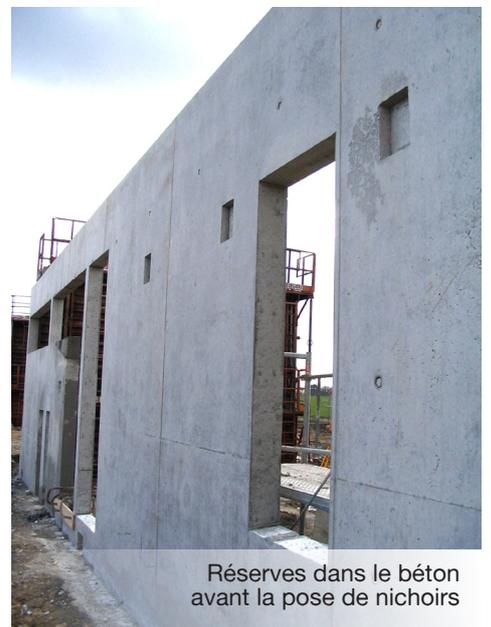
Réserves dans le béton avant la pose de nichoirs
