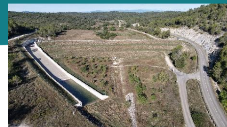
Le barrage de Saint Geniès de Malgoirès
